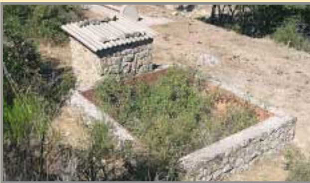
Pozo invadido por la vegetación y caseta de bombas en Arroyo Maderones, de Colmenar Viejo. Foto: R. Jiménez, 2004.
