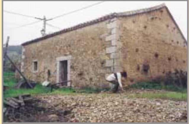
Restos de escombrera de la mina "La Chilena", en El Cuadrón, mina famosa por sus bismutinas cristalizadas y esfaleritas cadmíferas. Foto: L. Jordá, 2003.
