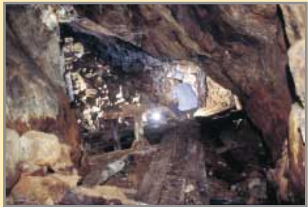
Perspectiva de la galería de arrastre del tercer nivel, que tiene acceso por una bocamina por la que también desaguaban las labores. Foto: L. Jordá, 2003.
