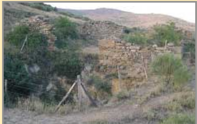
Brocal y ruinas de la casa de máquinas del Pozo "La Cazadora", en Horcajuelo. Foto: R. Jiménez, 2004.
