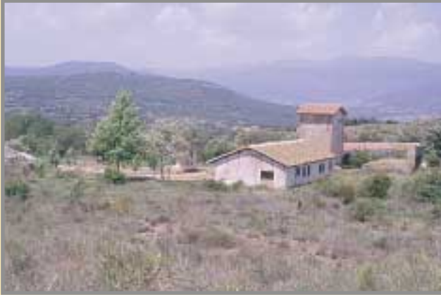
Excelente estado de conservación de las instalaciones exteriores de la mina de cobre "Fernandito", en Garganta de los Montes. Foto: L. Jordá, 2003.
