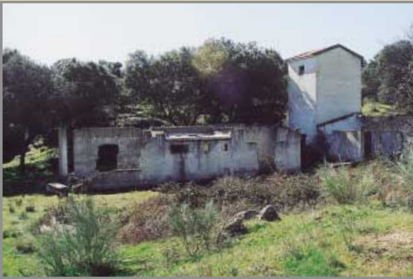
Restos del transformador y oficinas de la mina "San Eusebio", en Colmenar del Arroyo. Aunque inicialmente produjo mineral de Pb-Zn, con posterioridad se benefició la abundante fluorita de la ganga de los filones. Foto: L. Jordá, 2003.
