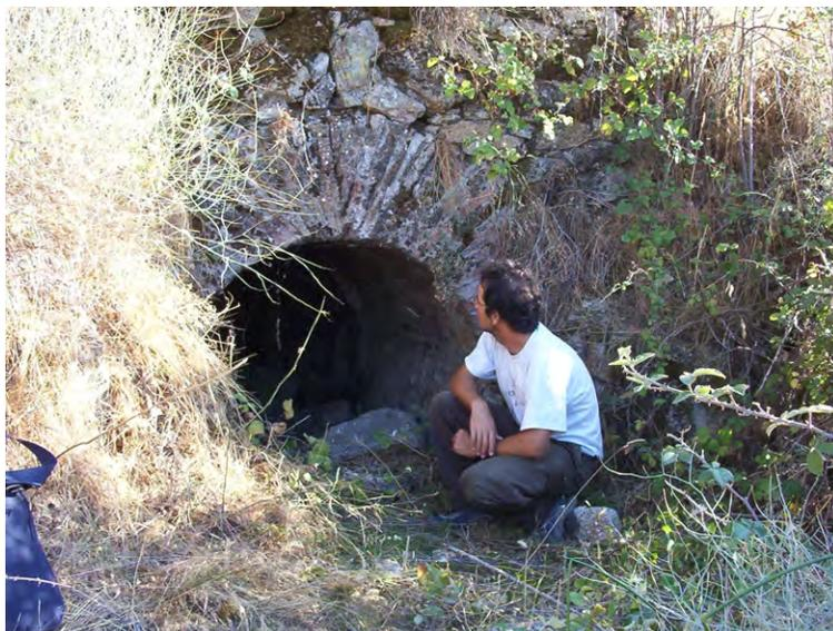
Figura 133: Emboquille de la galería inferior de Peñalvero. Fotografía tomada en 2005. Visitamos de nuevo la mina en 2006. En 2007 se derrumbaron 10 m de galería.
