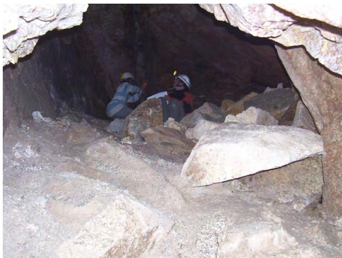
Figura 25: Realización de una estación geomecánica en un realce de la mina de San Marcelino, en Colmenar Viejo.
