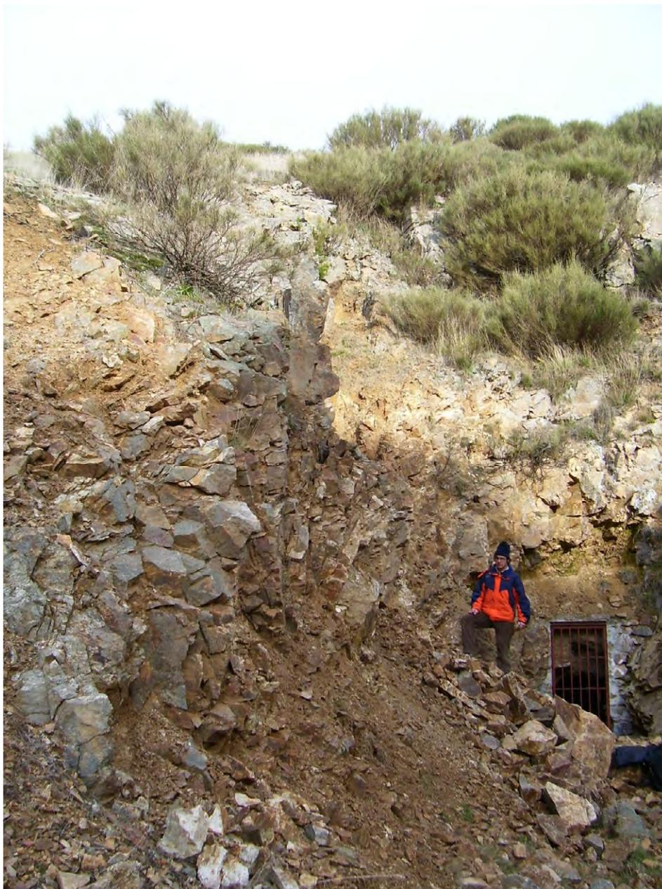
Figura 179: Aspecto que ha presentado el emboquille de la mina de Bustarviejo hasta finales de 2007. Nótese la caída de bloques y la degradación del macizo rocoso por gelifracción. (fotografía tomada en 2006).
