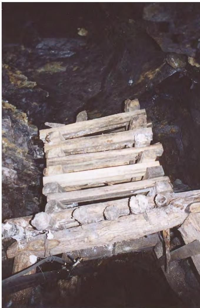
Figura 54: Llave para transmitir cargas en una zona sobre excavada. Típico en zonas de filones, vetas y cuñas de roca.
